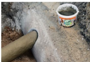
Do vysekaného průrazu v horní třetině nasunout přípojné potrubí.
