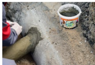
Za pomoci WATER STOP dokonale vyplnit všechny mezery i praskliny a povrch uhladit...
