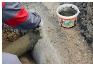
Z rozmíchané hmoty WATER STOP si vymodelovat „válečky“ a vytvořit prstenec kolem napojení.
