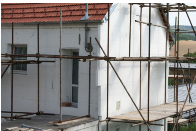
ŠPATNĚ - Absence provázání desek na rohu objektu
