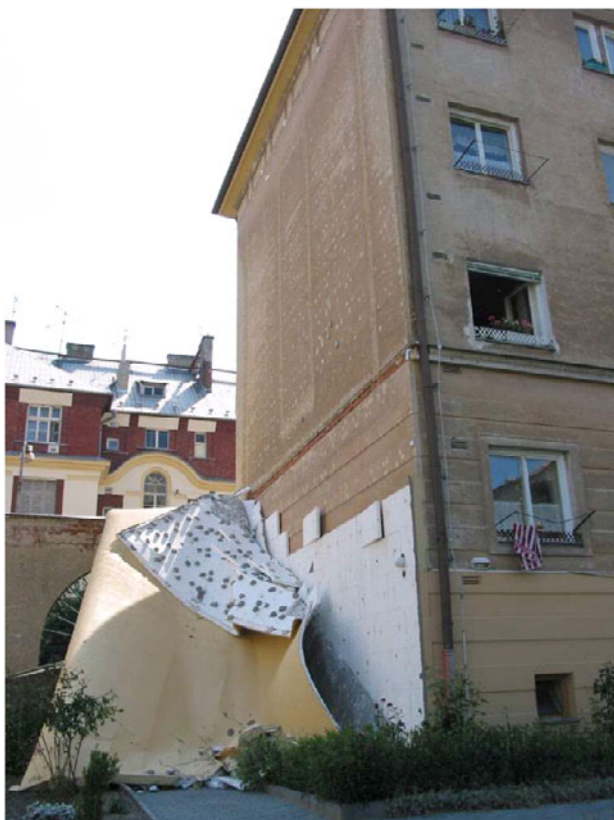
Nedostatečné lepení, chybí pás po obvodu desky. Malé množství lepidla.
