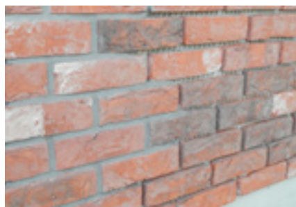
Zdivo s raženým obkladovým páskem.
