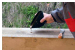
Vývrt vyplnit cca z 1/3 kotvicím cementem.
