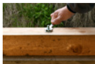
Nasadit podložku a utáhnout matici...
