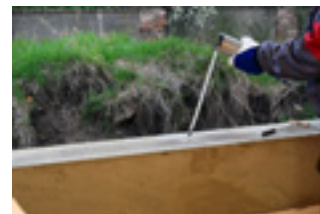
...pomocí pumpičky vyfoukat prach z vývrtů...
