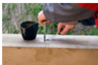
Okamžitě po ukotvení, očistit okolí vývrtu od přebytečné hmoty.
