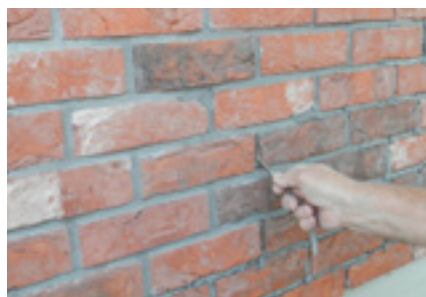
Pro styčné spáry volte kratší spárovací lžíci.
