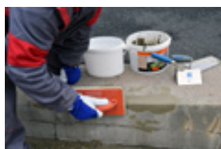
Dle potřeby můžete vnést do povrchu trochu vody pomocí kroupení, aby se povrch lépe uzavřel...
