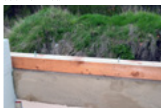
Po vytvrdnutí PUR STONE uložit pozednici.
