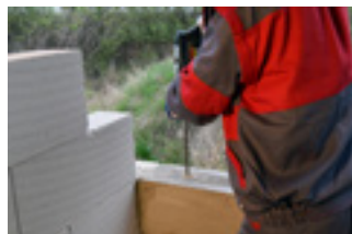
Vyvrát otvor pro ukotvení pozednic do požadované hloubky.
