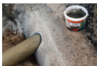
Do vysekaného průrazu v horní třetině nasunout přípojnou potrubí.
