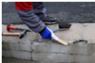
Pomocí ocelového kartáče odstranit uvolněné části.
