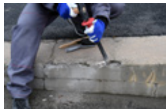
Osekát slabé části narušeného betonu.
