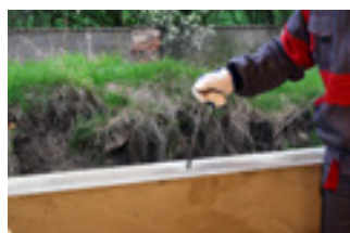
...a odstranit uvolněné částice pomocí kartáčku.
