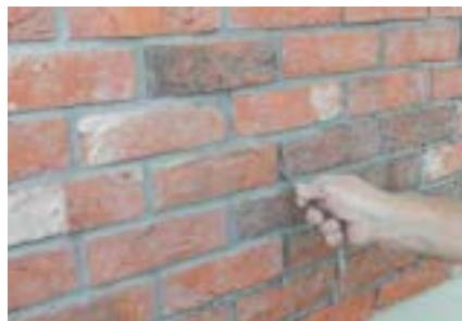
Pro styčné spáry volte kratší spárovací lžíci.
