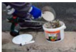
Podle typu a rozsahu oprav zvolit plnivo (písek, štěrk) odpovídající frakce.
