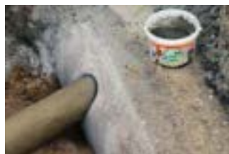
Do vysekaného průrazu v horní třetině nasounou přípojné potrubí.
