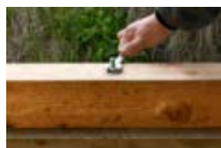
Nasadit podložku a utáhnout matici...
