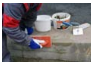
Dle potřeby můžete vnést do povrchu trochu vody pomocí kropení, aby se povrch lépe uzavřel...
