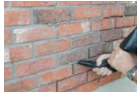
Pomocí spárovacího rukávu (pytle) postupně vytlačujte mokrou směs do spár.
