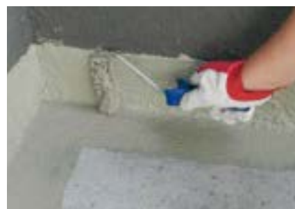
3. Izolace exponovaných míst: Nanést nátěr do koutů a vytáhnout jej cca 15 – 20 cm od lomu nebo dilatační spáry na každou stranu.
