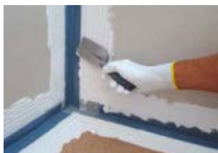
4. Vložit těsnící pás do čerstvého nátěru.
