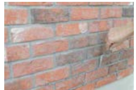
Jakmile je hmota již dostatečně tuhá, můžete povrch zdrsňit lehkým proškrábnutím nebo např. hrubým kartáčem apod.
