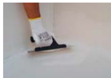
6. Po zaschnutí prvního nátěru nanést celoplošně druhou vrstvu nátěru.
