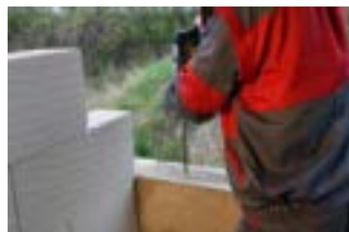
Vyvrát otvory pro ukotvení pozednic do požadované hloubky.
