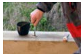
Do vývrtnu ihned zasunout šroubovým pohybem závitovou tyč nebo jiný kotvicí prvek.
