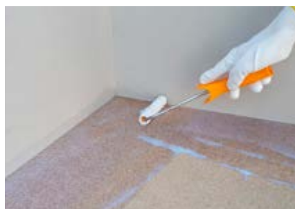
2. Příprava podkladu vhodnou penetrací.
