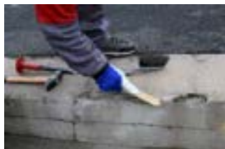
Pomocí ocelového kartáče odstranit uvolněné části.
