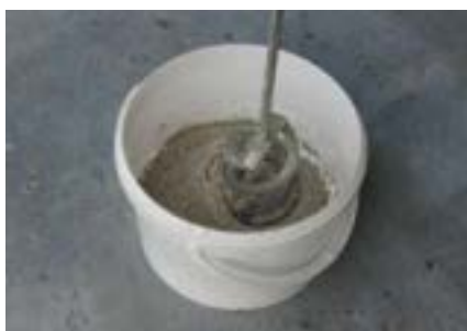
2. Příprava směsi: Vsypat sypkou složku do tekuté a důkladně promísit v hladkou homogenní hmotu.
