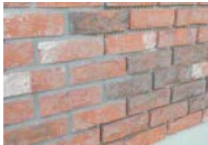
Zdivo s raženým obkladovým páskem.
