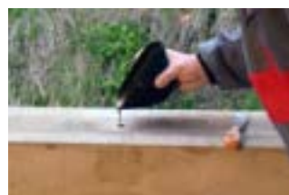
Vývrt vyplnit cca z 1/3 kotvicím cementem.
