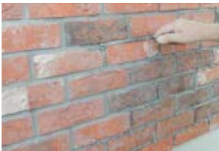
Upravte ložné spáry do požadovaného tvaru.
