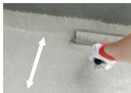
6. Celoplošná izolace: Provést druhý celoplošný nátěr kolmo k prvnímu nátěru.
